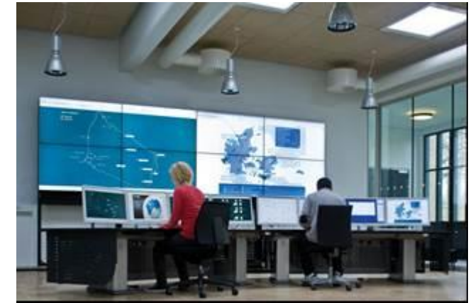
réplique du centre de contrôle du Smart Grid de Bornholm au DTU de Lyngby près de Copenhague (photo DTU)
